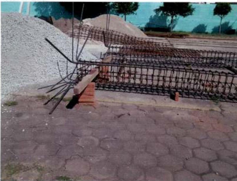
HABILITADO DE ACERO
