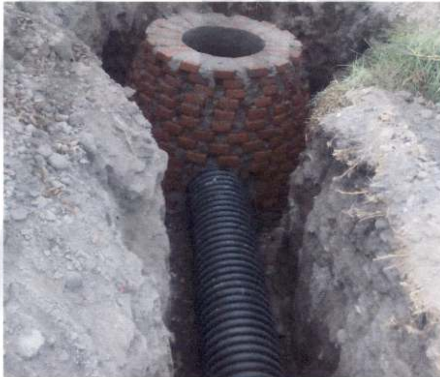
POZO DE VISITA TIPO COMUN Y PROFUNDIDAD DE HASTA 1.50 M
