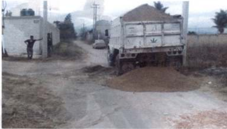
SUMINISTRO Y COLOCAION DE PLANTILLA DE ARENA EN ZANJAS PARA TUBERIA
