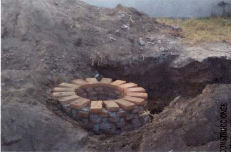
POZO DE VISITA TIPO COMUN Y PROFUNDIDAD DE HASTA 1.50 M
