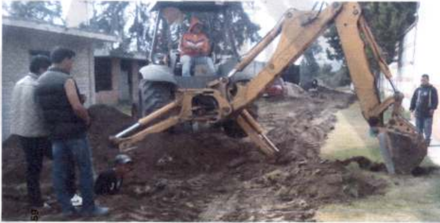
EXCAVACION EN ZANJAS CON EQUIPO, EN MATERIAL COMUN SECO, ZONA A, PROFUNDIDAD DE 0.00 A 6.00M
