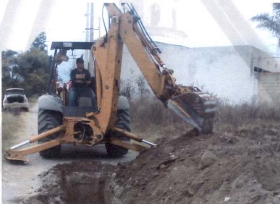
EXCAVACION PARA DESPLANTE DE ESTRUCTURAS EN MATERIAL COMUN SECO.
