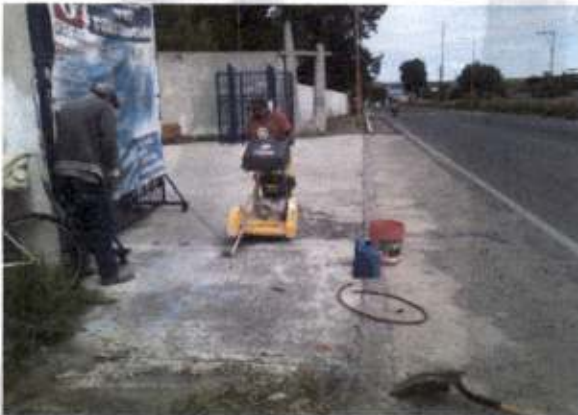
CORTE CON CORTADORA DE DISCO EN PAVIMENTO DE CONCRETO A 10 CM. DE ESPESOR.
