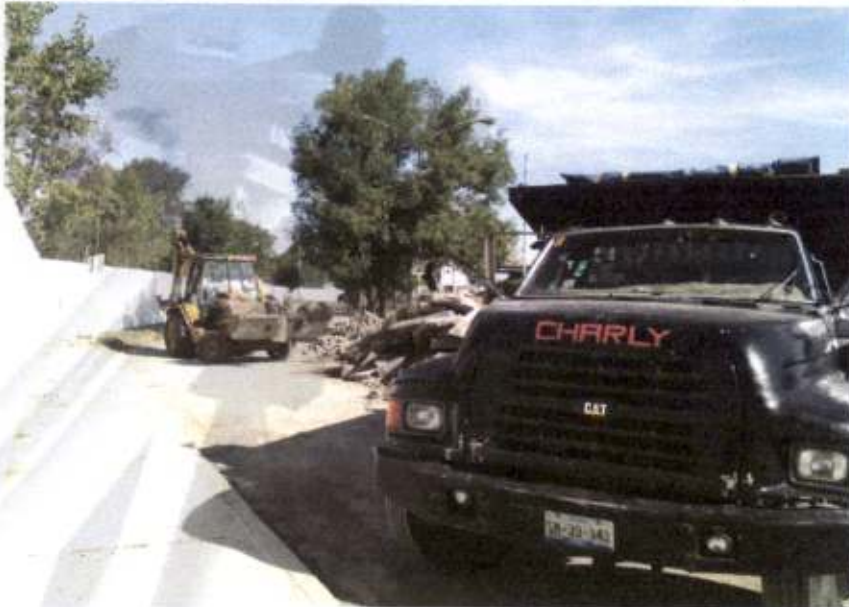
ACARREO EN CAMION DE MATERIAL MIXTO. PRIMER KILOMETRO, CARGA MECANICA
