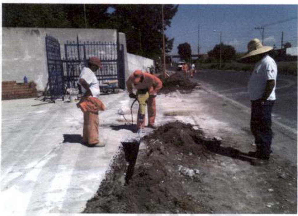
RUPTURA Y DEMOLICIÓN CON EQUIPO EN PAVIMENTO HIDRÁULICO
